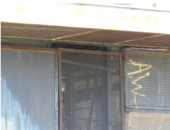
Abbildung 32: Einflugmöglichkeit an zum Abriss vorgesehenem ehemaligem Stellwerk
