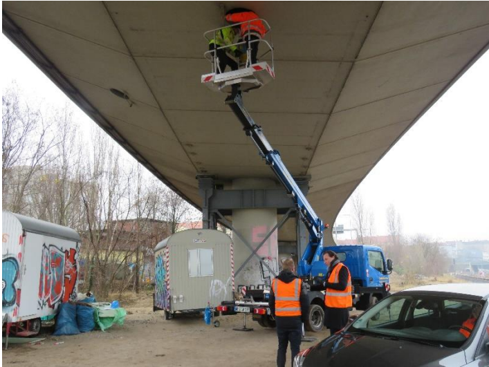
Abbildung 30: Hohlräumkontrolle Westendbrücke, Zugang per Hubsteiger
