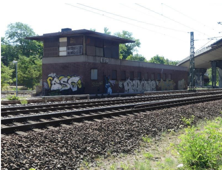
Abbildung 31: Ehemaliges Stellwerk nördlich der Westendbrücke
