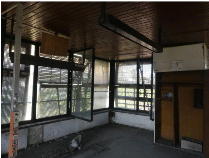
Abbildung 34: Ansicht des Innenraums des Turms
