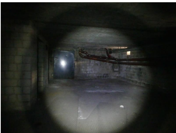
Abbildung 35: Keller des Stellwerks (Teilbereich)
