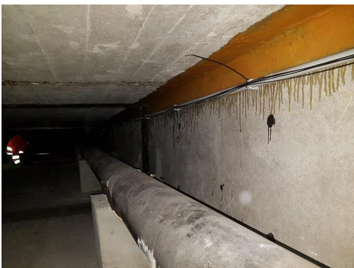
Abbildung 29: Hohlraumkontrolle Westendbrücke
