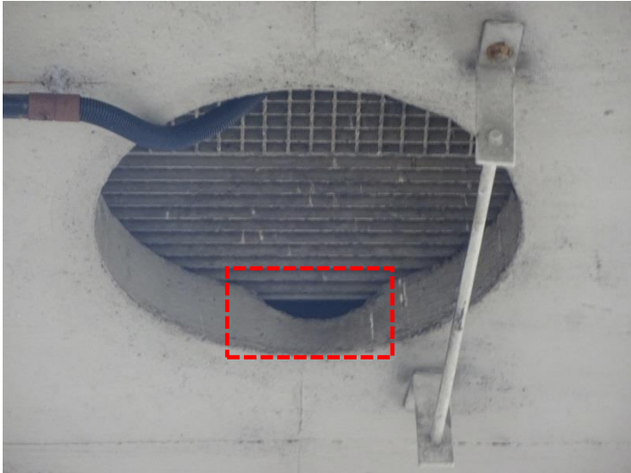
Abbildung 16: Spalt an Gitteröffnung (Einflugmöglichkeit)
