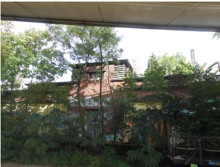
Abbildung 5: Abrissgebäude, Werkstatt (in Betrieb)
